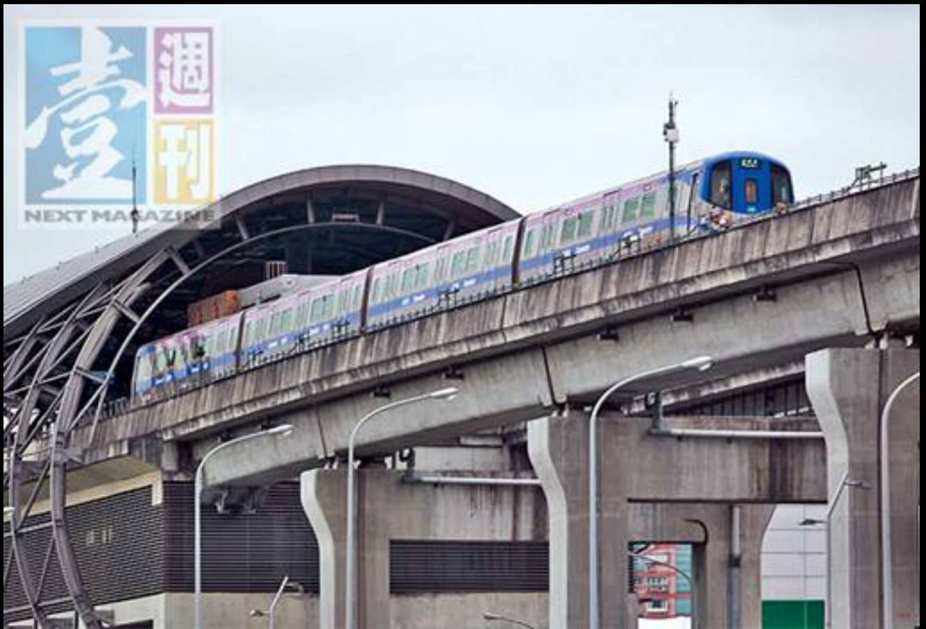
軌道交通高架：以捷運為例 (照片取自網路報導)
