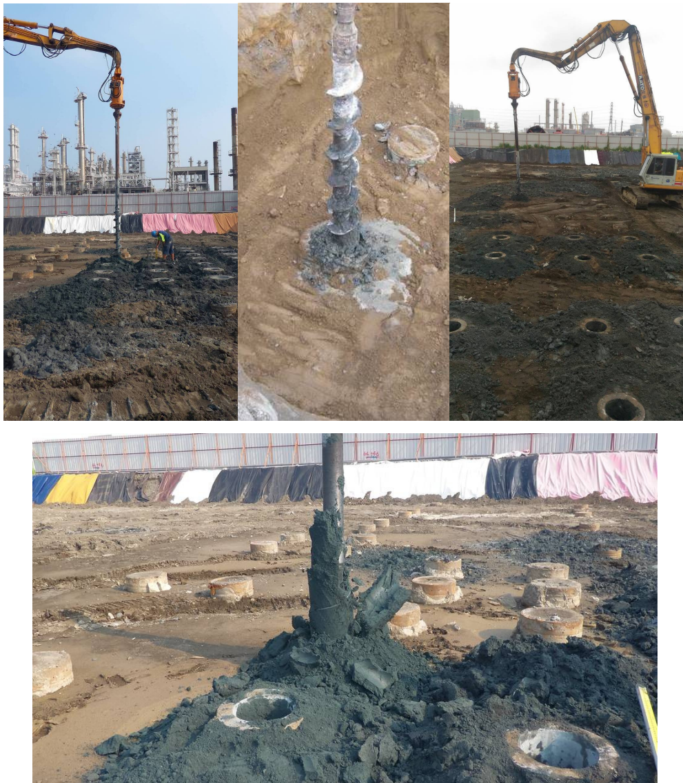
▲圖 1-1: 傳統植樁：二次鑽芯處理及機具
