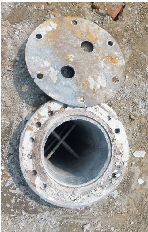
▲圖 1-10: DH 快速基樁之開蓋後的中空樁頭露出 ▲圖 1-11: DH 快速基樁之預置水平筋
