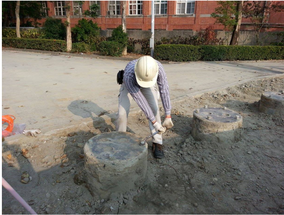
▲圖 1-9: DH 快速基樁的開蓋 (人工示範例)
