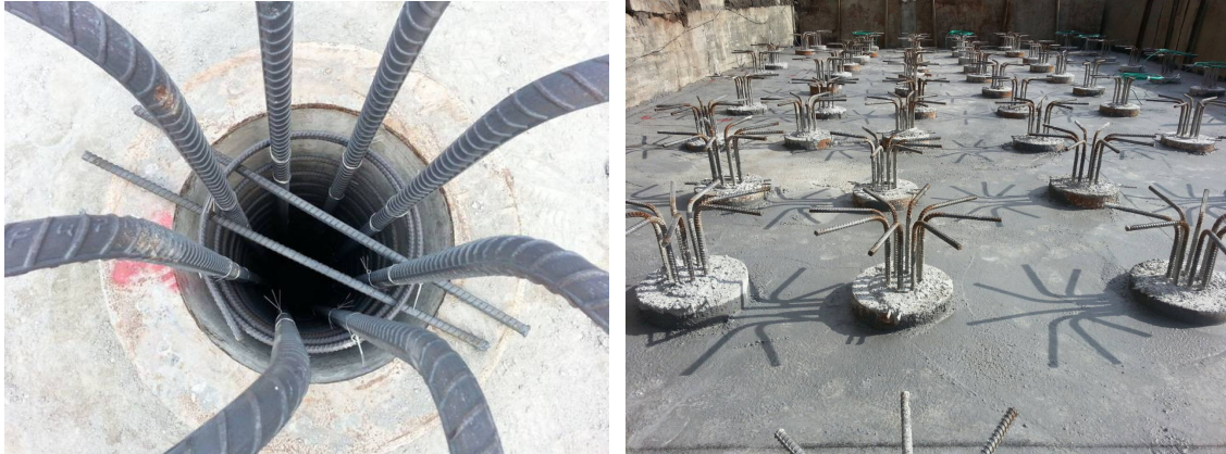
▲圖 1-3: 傳統植樁：樁頭置入鋼筋籠及灌填芯混凝土
