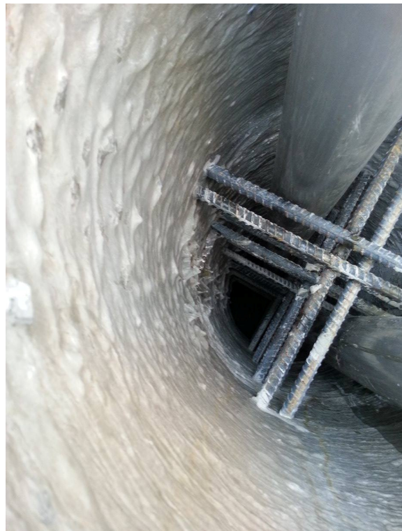
▲圖 1-10: DH 快速基樁之開蓋後的中空樁頭露出 ▲圖 1-11: DH 快速基樁之預置水平筋
