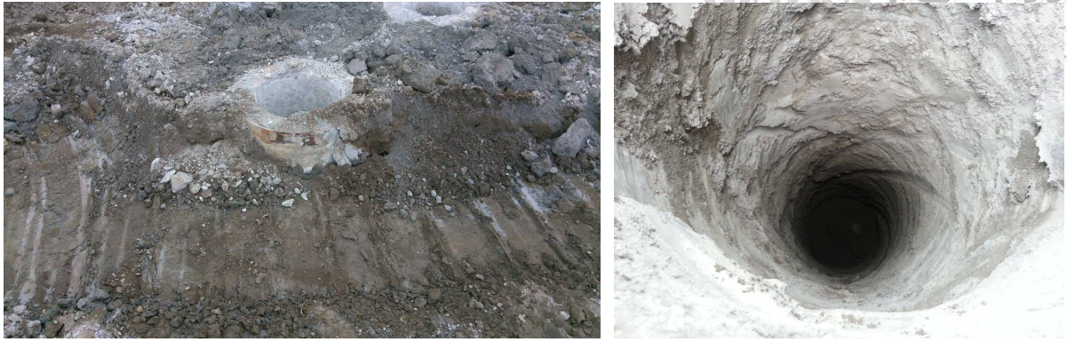
▲圖 1-2: 傳統植樁：鑽芯清孔後的樁內壁
