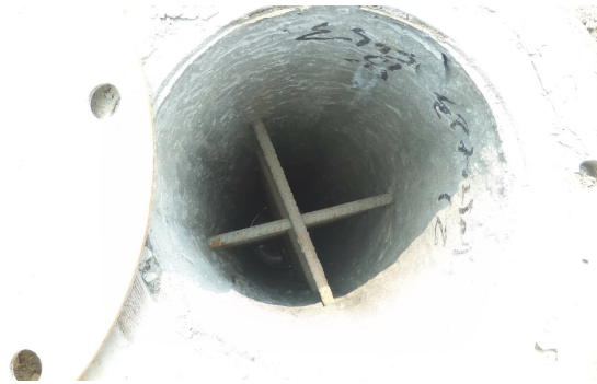
▲圖 2-1: DH 快速基樁中空樁頭的組成 ▲圖 2-2: DH 快速基樁中空樁頭開蓋後露出
