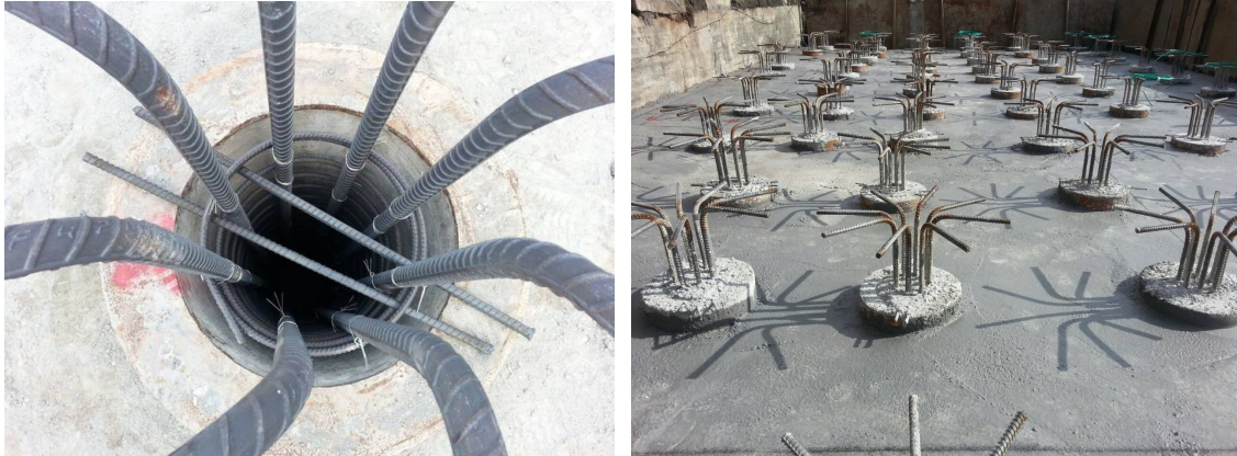
▲图 1-3: 传统植桩：桩头置入钢筋笼及灌填芯混凝土
