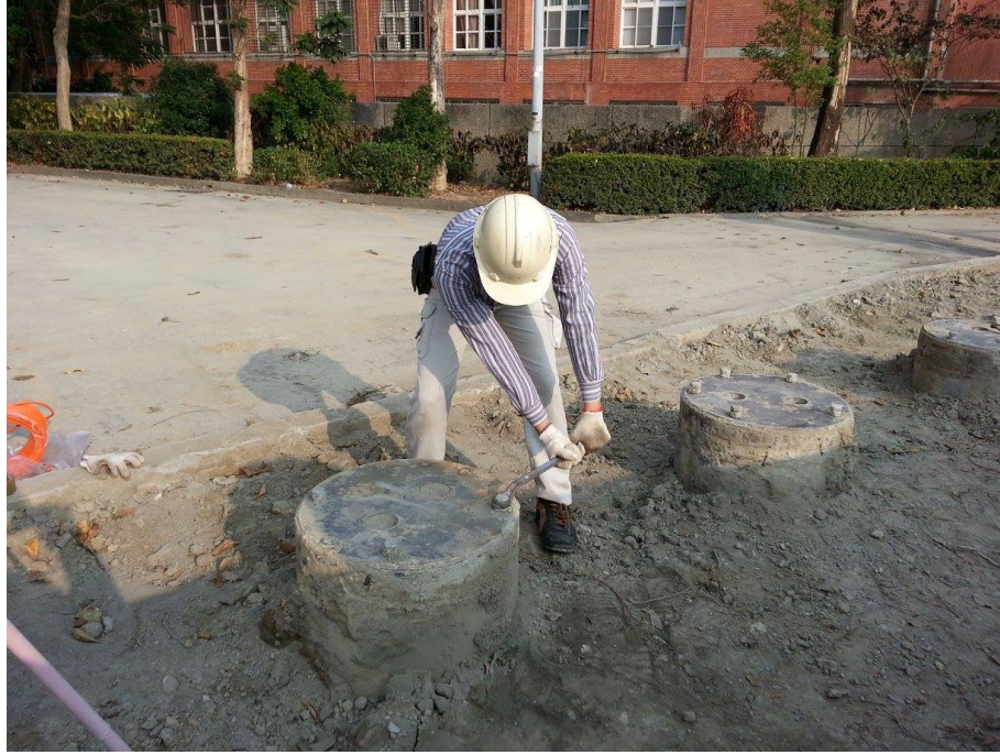
▲图 1-9: DH 快速基桩的开盖 (人工示范例)
