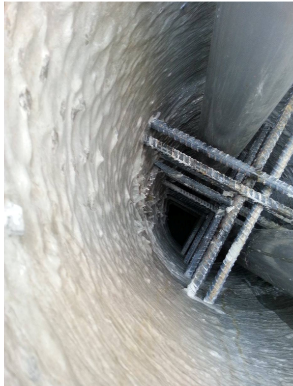
▲图 1-11: DH 快速基桩之预置水平筋
