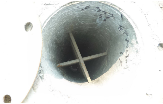
▲图 2-1: DH 快速基桩中空桩头的组成 ▲图 2-2: DH 快速基桩中空桩头开盖后露出
