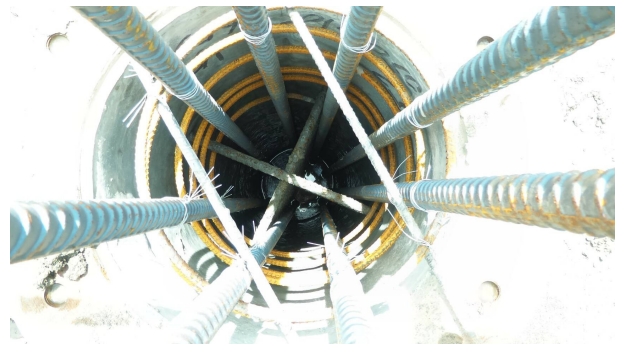
▲图 0-2: DH 快速基桩第三代产品(2016)，排气孔在上方
