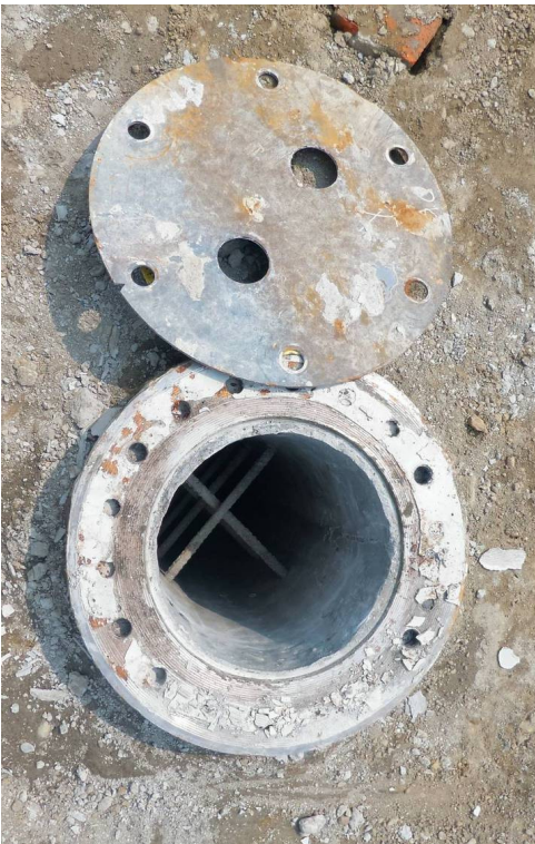
▲图 1-10: DH 快速基桩之开盖后的中空桩头露出
