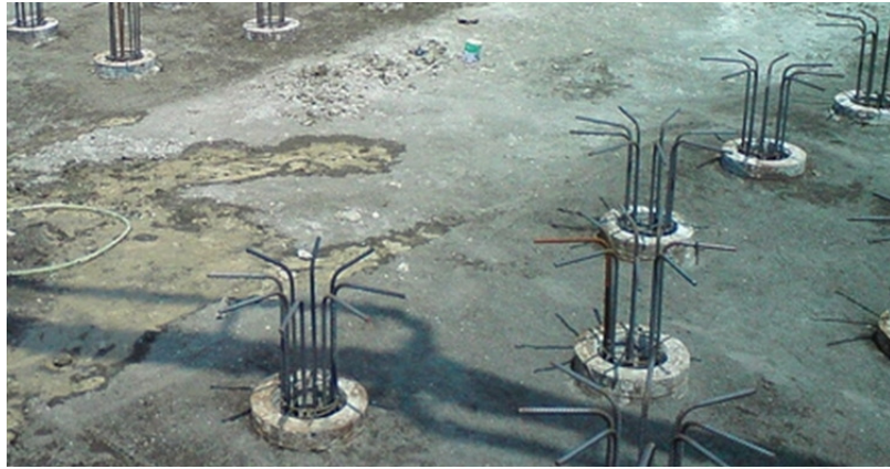
圖 7 傳統植入式預力基樁樁頭處理完成情形
