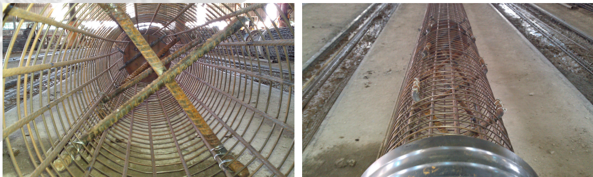
圖 5 DH 基樁工廠作業時樁頭鋼筋籠組立情形[8]
