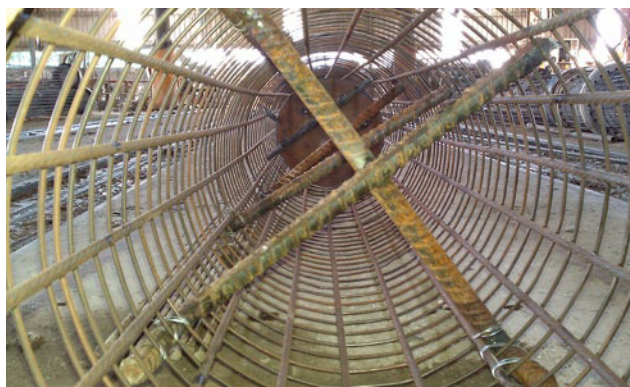
图 4 DH 基桩工厂作业时桩头钢筋笼组立情形 [8]
