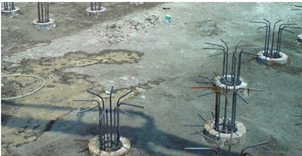
图 7 传统植入式预应力基桩桩头处理完成情形
